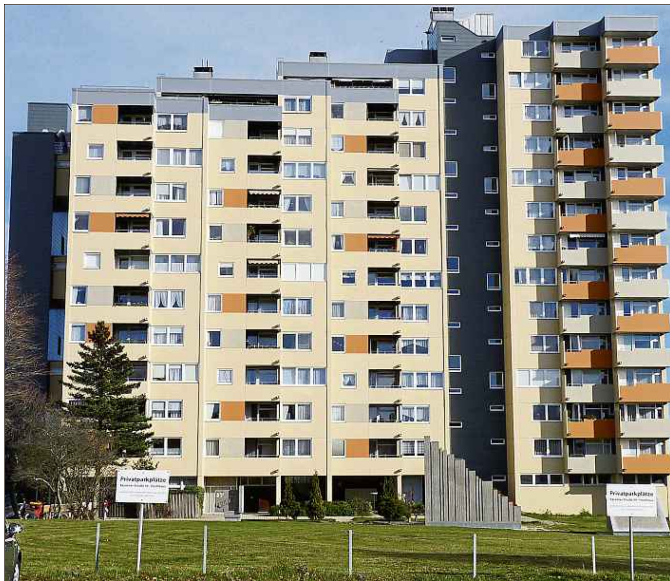
Die Westfassade des Hochhauses an der Kärntner Straße wurde saniert und erstrahlt in neuem Glanz.
